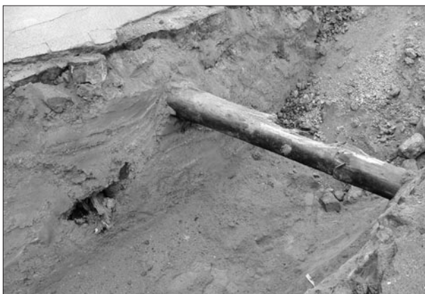
Obr. 75. Zásmyky, okr. Kolín, náměstí. Dvě dřevěná vodovodní potrubí uložená nad sebou (spodní poškozené při hloubení rýhy, novověk)
