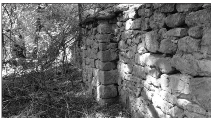
Obr. 14. Lánská obora. Oborní sloupky (pilíře) u Vašírovských lís, které v pravidelných vzdálenostech zesilují oborní zeď a brání tak jejímu zřícení. Foto: autor, květen 2010
