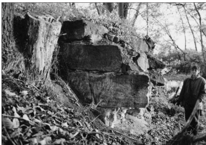
Obr. 6. Byšičky. Pohled na severozápadní okraj mostu, stav 1998
