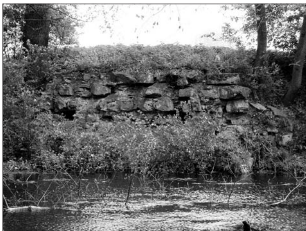
Obr. 5. Byšičky. Pohled od jihozápadu na pozůstatek tělesa mostu před vyčištěním
