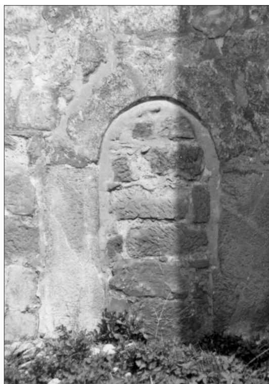
Obr. 17. Železnice. Zazděný románský portál v přízemí věže kostela sv. Jiljí, 26. 4. 1995. Fotoarchiv RM a G v Jičíně
