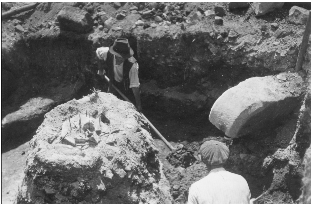
Obr. 7. Fotografie výkopu základové jámy pilíře zachycující objemný architektonický prvek (konsolu) odkrytý při zakládání stavby observačního pilíře roku 1942. Dokumentace TB 17, Zeměměřický úřad v Praze
