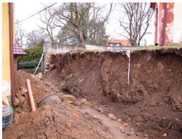
Obr. 4. Hrusice, okr. Praha-východ. Situace jihozápadní strany bývalého hřbitova u kostela sv. Václava po zboření úseku ohradní zdi v únoru 2020. Pohled od jihu před zahájením záchranného výzkumu. Foto E. Kuklová.
