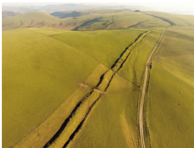
Obr. 12. Offova hráz – velká liniová stavba ve Velké Británii, která zhruba sleduje současnou hranici mezi Anglií a Walesem. Pohled z vrchu Lanfair Hill směrem k jihu. Foto z dronu: Julian Ravest, Offa's Dyke Journal 2019.
