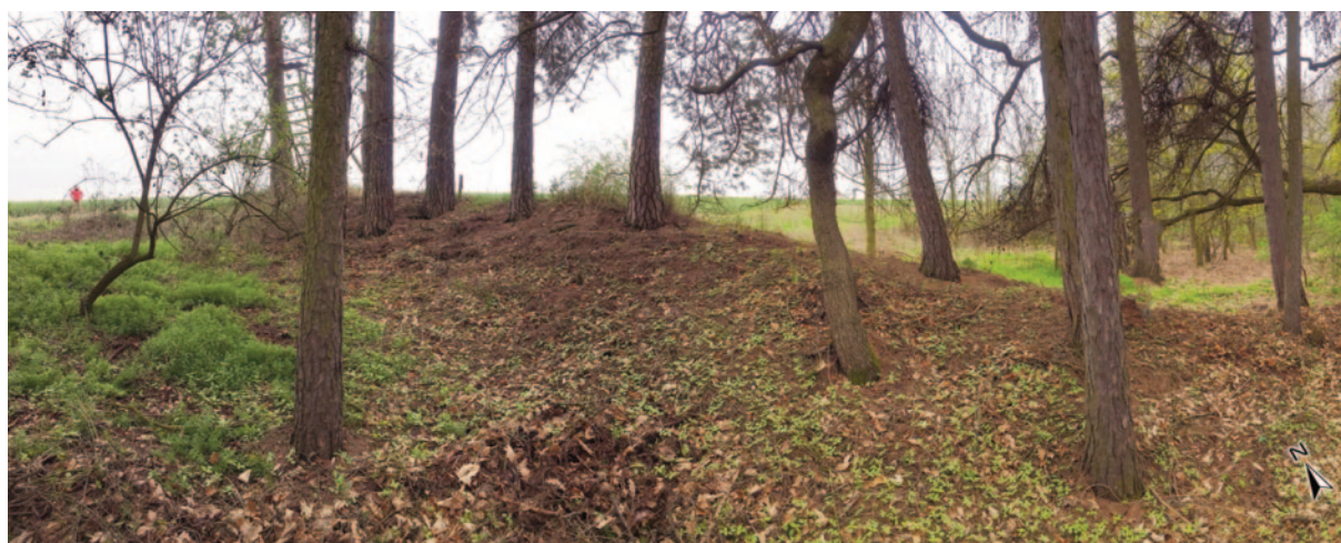
Obr. 5. Valové těleso s mělkými příkopy v roklí u Vitic na jihozápadě liniového útvaru (pozice A). Výška valu dosahuje 1,4 m. Foceno z rokle směrem nahoru k okraji pole, orientace fotografie k severovýchodu. Foto Č. Štuka 2015.
